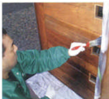
洗浄剤塗布・浸透
